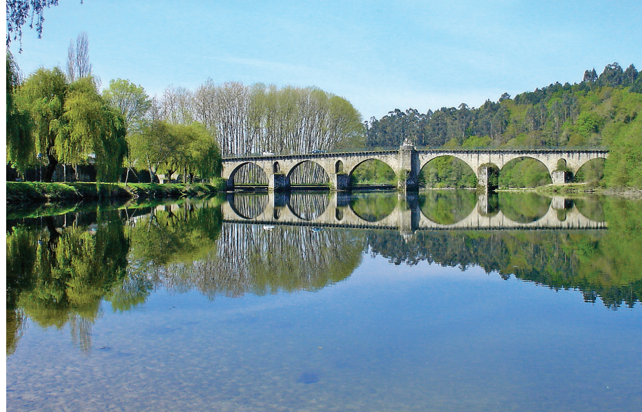
Ponte sobre o Lima – Ponte da Barca
